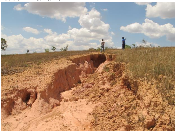
Foto 17: Detalhe de foco erosivo situado na Sub Bacia do Alto do Rio Bicudo, município de Morro da Garça. – 19/10/16
