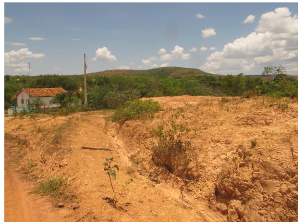
Foto 4: Área demarcada para correção de bigode para direcionamento da drenagem no sentido da barraginha existente. – 18/10/16
